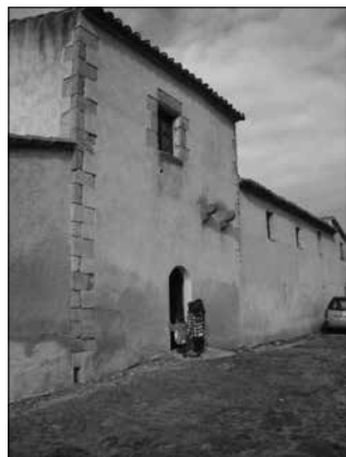
Figura 1. La capella de Sant Vicenç i la torre de l'antiga casa forta de Vilabella
